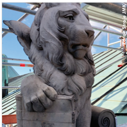
Při sanaci starých budov se JETLaser používá také k čištění pískovcových fasád, mramoru a jílu. (Socha – před a po.)
